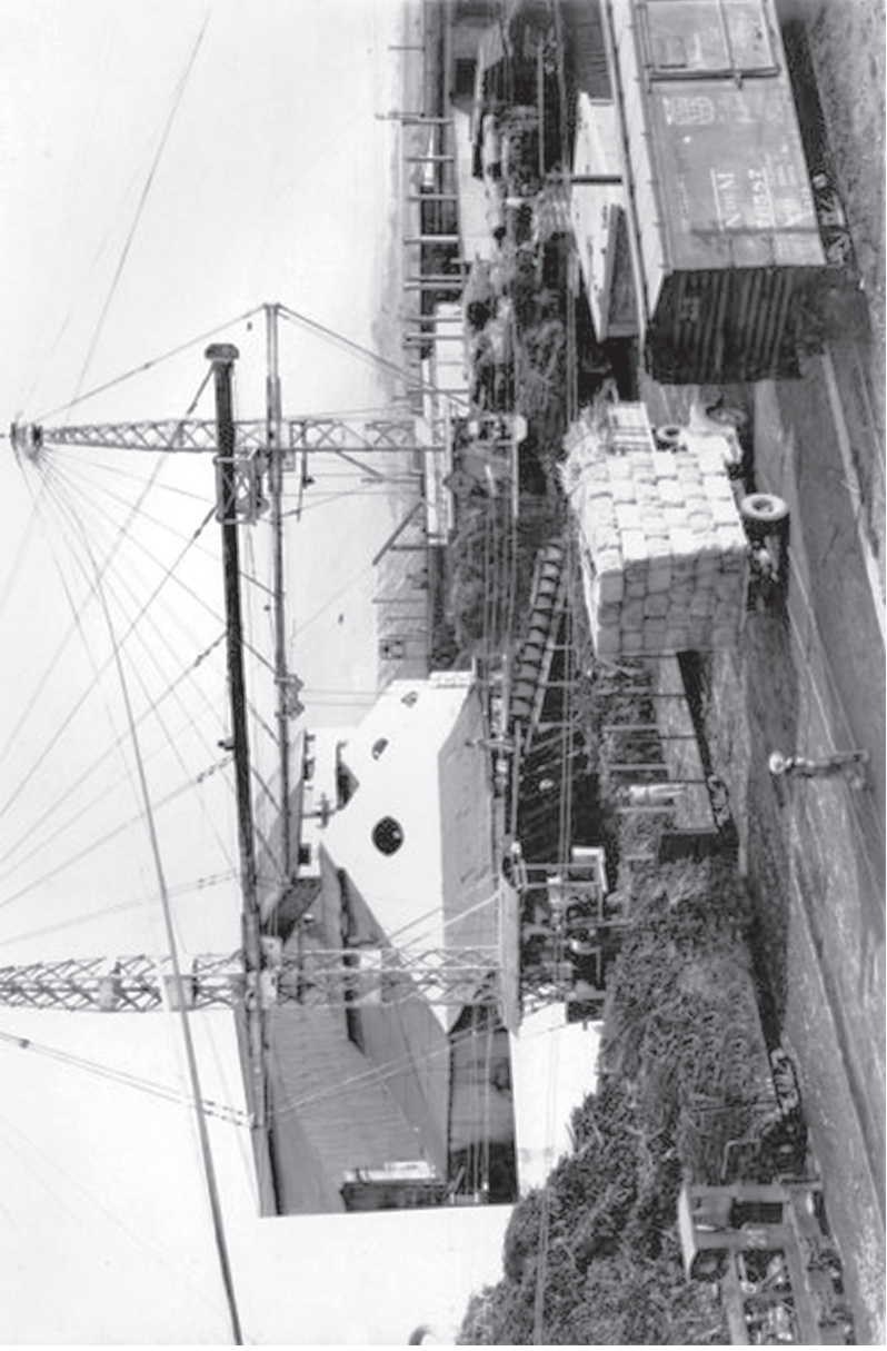
FOTOGRAFÍA 2. Área del batey del ingenio de Atencingo, donde se observan locomotoras y camiones que transportan las materias primas, así como la antigua bodega de azúcar, la grúa alzadora de caña y la banda transportadora de la gramínea. Fuente: Archivo particular de la Mtra. Martha Elba del Río Mendieta.
